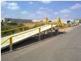
Rampa de carga fija de 12m de longitud y 10 toneladas de capacidad.
